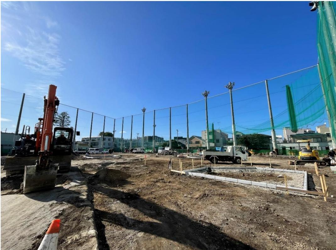
ショベルカーで削った地面に、砕石を前期・後期工事合わせて約 1,700 トン敷き詰め、ロードローラーで振動を与えながら約 3 トンの圧力をかけて転圧し、土台を作っていきます。
