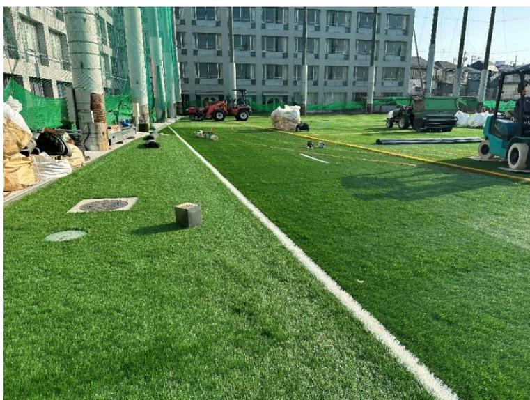
資材置き場のため敷設していなかった部分(写真右上の黄色い線より左側)の敷設作業も行っております。
